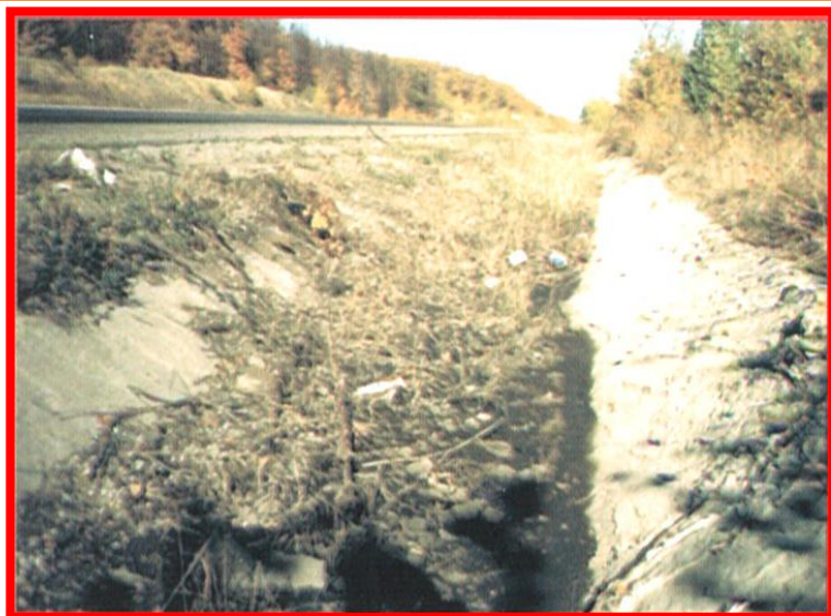
Не очищенная от мусора система водоотвода (водоотводные, прикромочные лотки, быстроток, нагорные канавы и т.д.)
